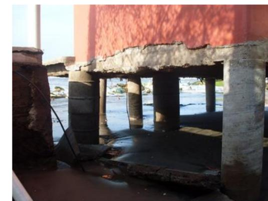
Figura 5.1.10.6. La erosión costera dejó al descubierto las cimentaciones (pilotes) de muchas viviendas.
