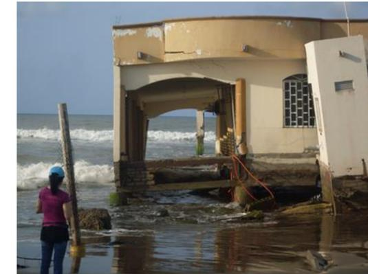
Figura 5.1.10.4. Ejemplos de daños a la infraestructura costera ocasionados por la erosión.
