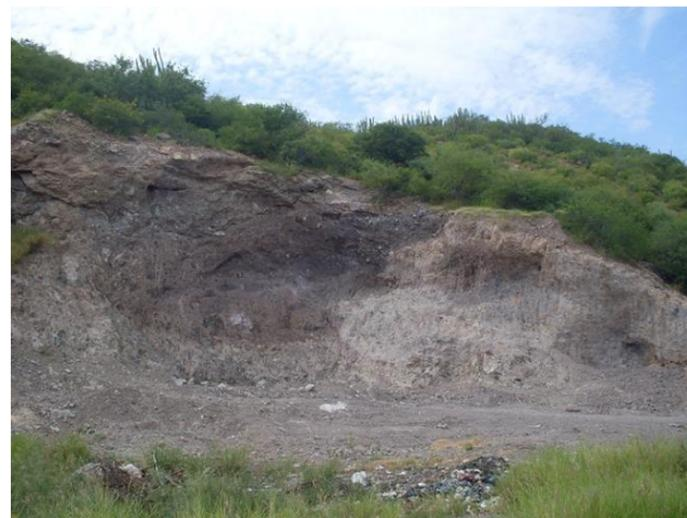
**Figura 5.1.6.7.- Zona de mina a cielo abierto, propensa a caídos y volteos.**
