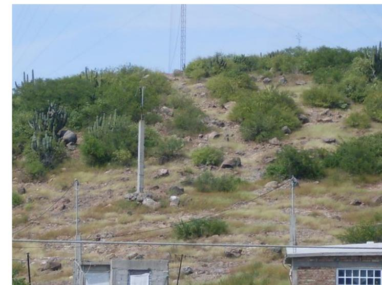
**Figura 5.1.6.9. Zona de bloques sueltos apoyados sobre la ladera.**
